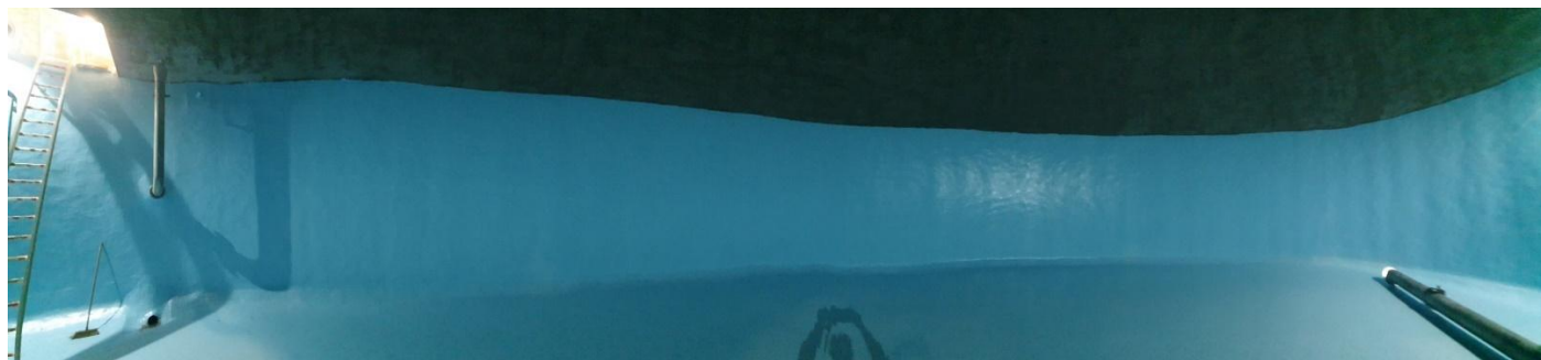
Réservoir de Piétat
